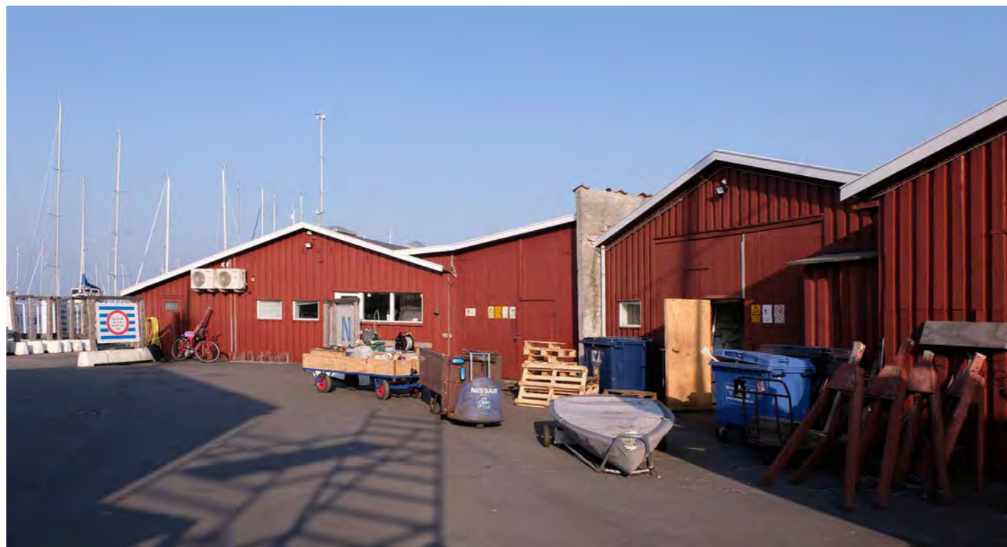
Bygninger som sammenbyggede gavlhuse
